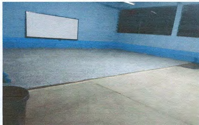
Foto 2: Área donde se está instalando el piso cerámico Aula 3
